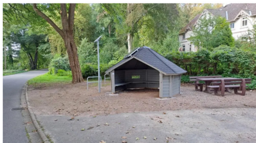
Ein Projektbeispiel, das gefördert wurde: der Rastplatz Ochsdorf. FOTO: EGW
